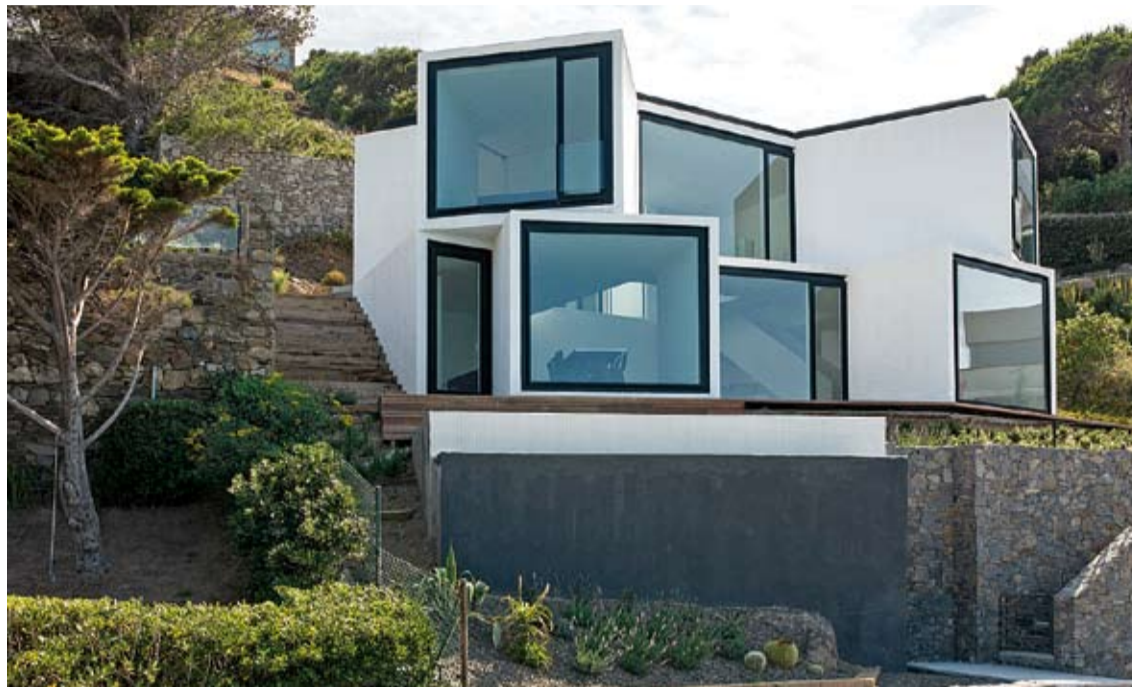
CASA GIRA-SOL. Projecte realitzat pels arquitectes Eduardo Caraval i Clara Solà-Morales. Port de la Selva
